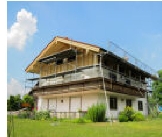
Das Mehrgenerationenhaus in Kirchanschöring wurde in Holzständerbauweise aufgestockt. BILDER: SCHWAIGER
